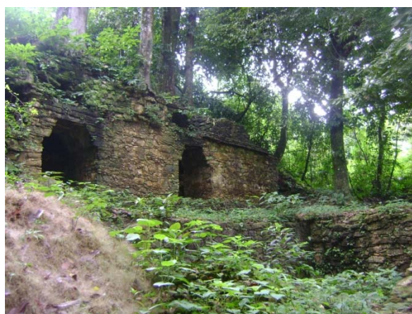
Fig. V. 21. Foto del edificio J2 del “Grupo IV” (Foto A. Campiani)
