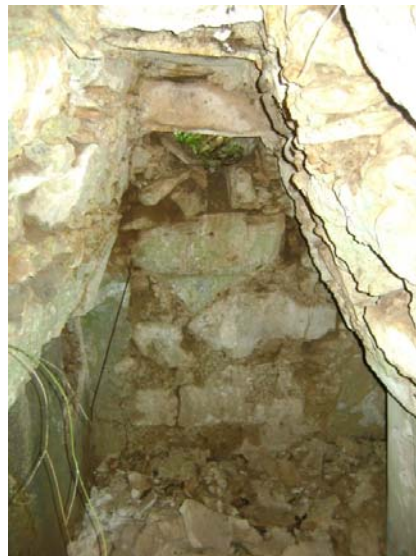
Fig.IV. 78. El espacio abovedado del conjunto CHK/K94 (Foto A. Campiani 2011)
