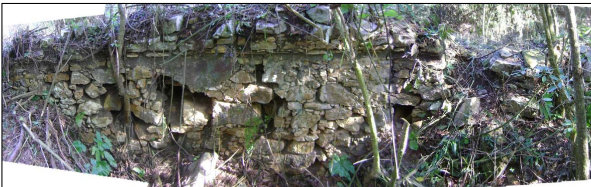
Fig.IV. 40. Muro central de la doble cruja abovedada de la estr. I-24 perteneciente al conjunto sobre basamento CHK/I118 (Fotomontaje A. Campiani 2010)
