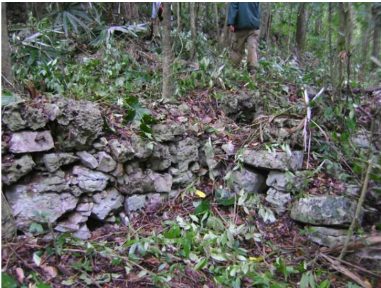
Fig.IV. 51. Mampostería de la estr. A-32 del conjunto CHK/A147 (foto A. Campiani 2010)
