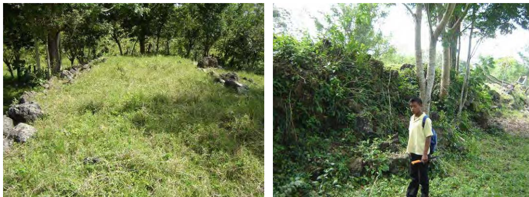
Fig. 7. 81 a) Parte superior del camino y la b) imagen del perfil N, el cual llega a tener 2.8 m de altura.
